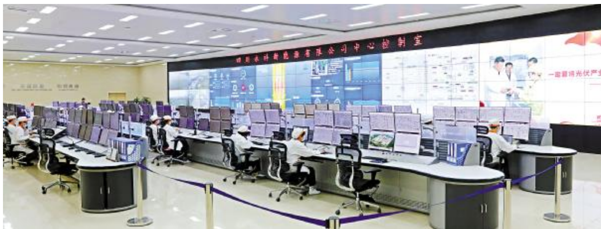
永祥新能源中心控制室是整个厂区的“运行大脑”
